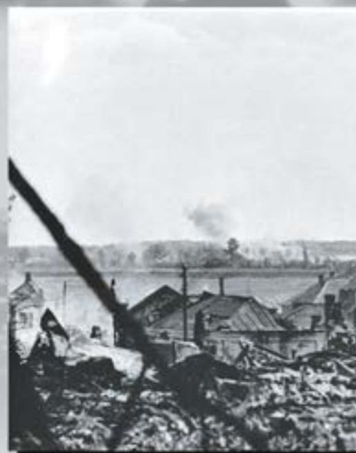
Разрушение г. Жлобы.
