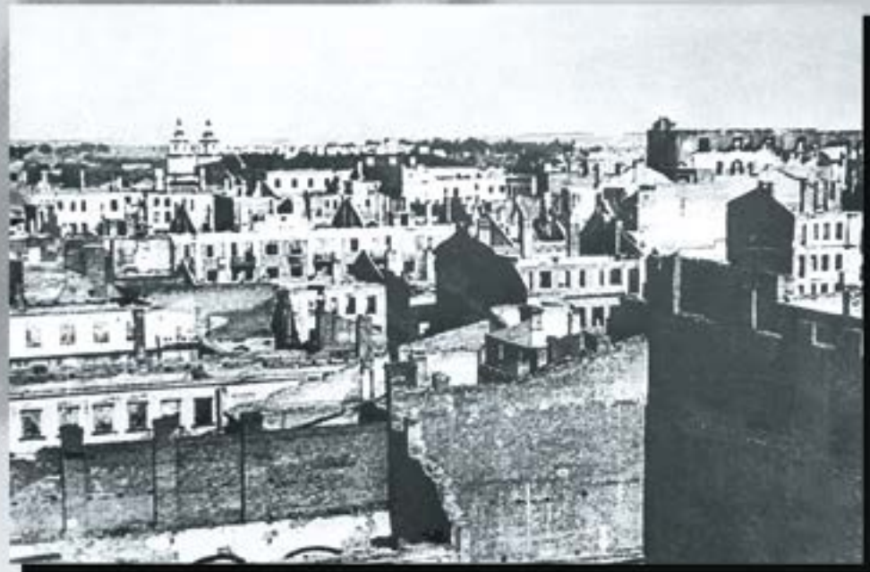
Разрушения в г. Минске
