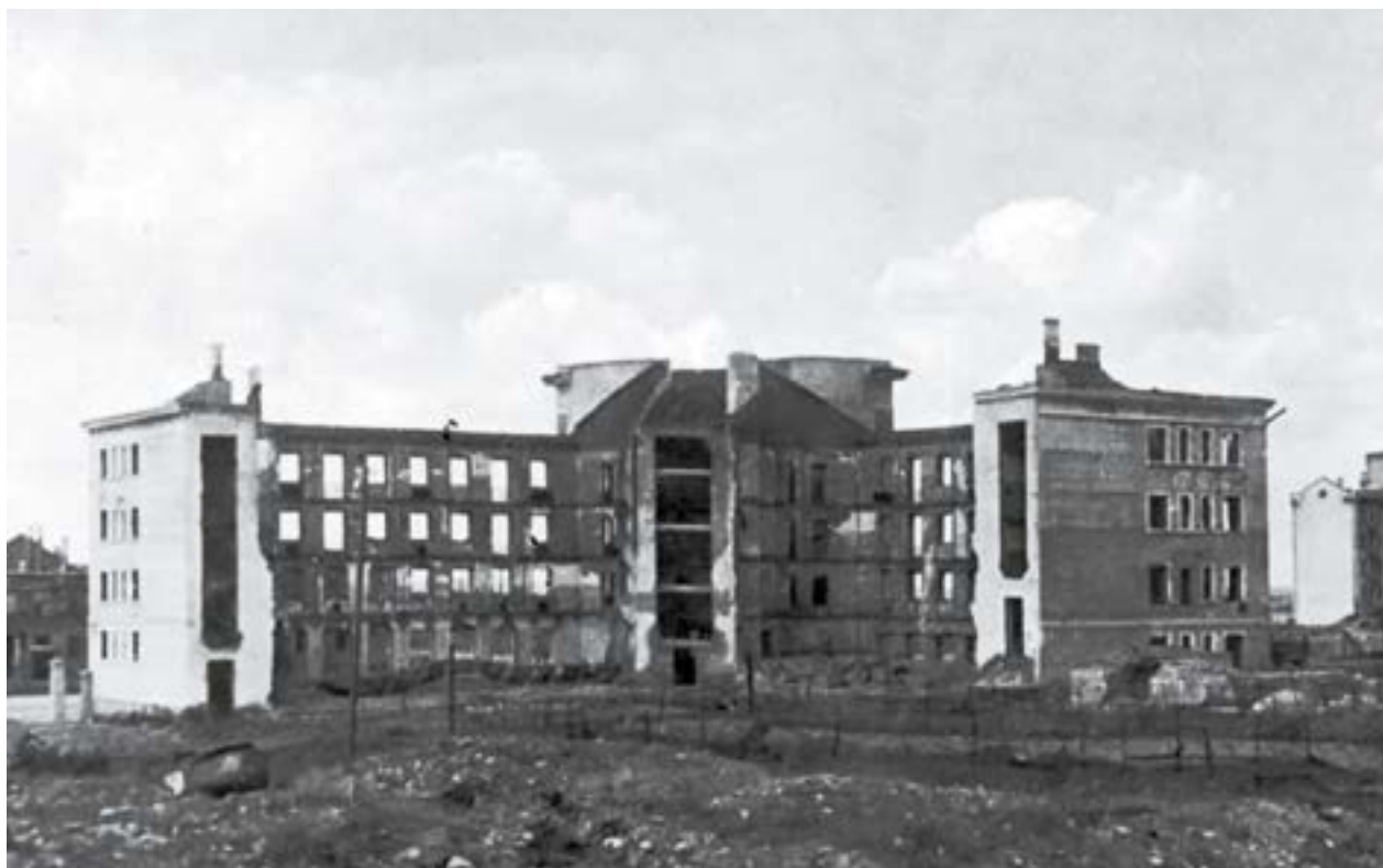
Вид на здание Министерства лесного хозяйства БССР на углу ул. К. Маркса и Комсомольской в г. Минске, разрушенное в годы Великой Отечественной войны (1944 г., АН 0-038496)
